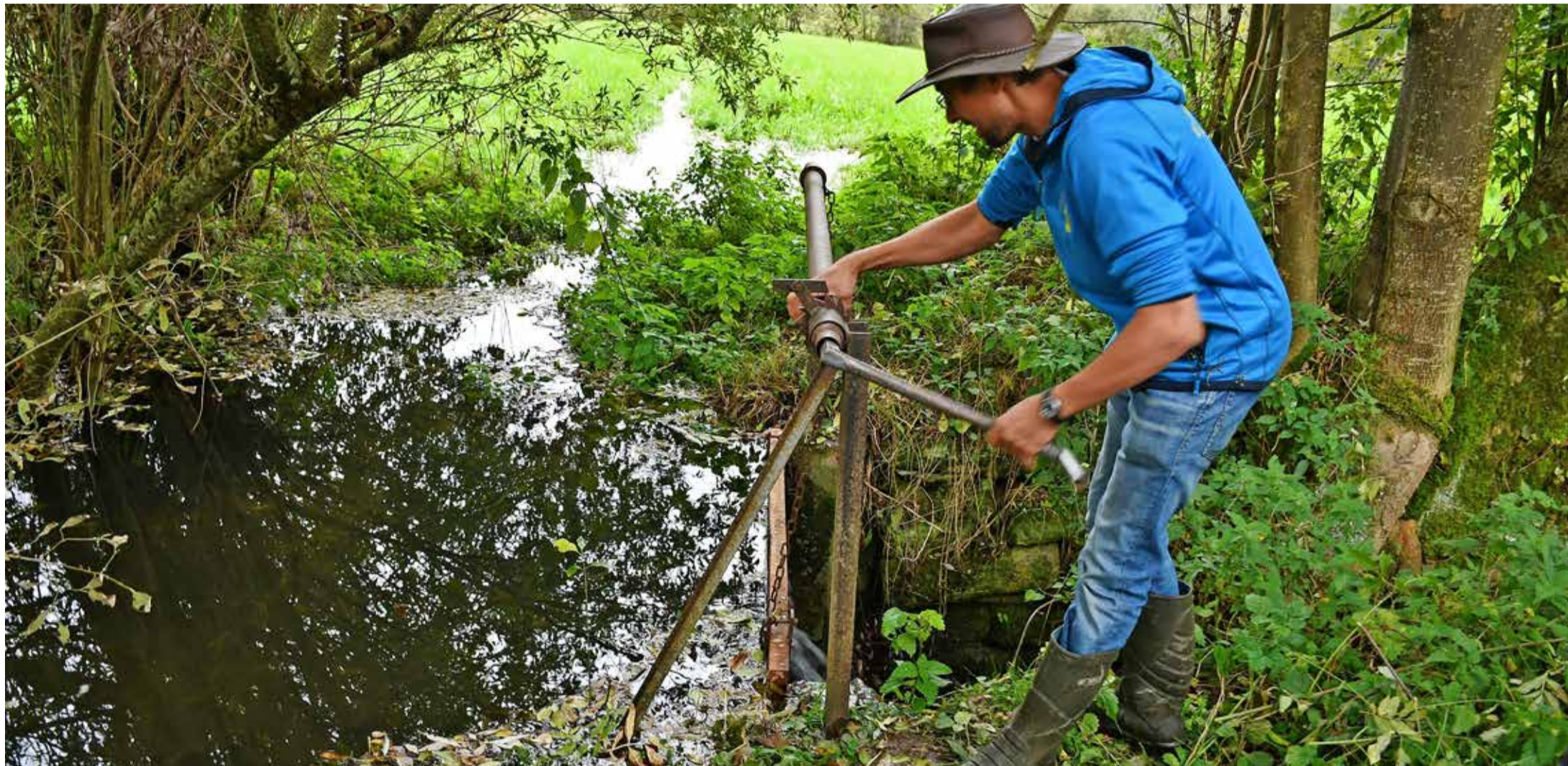
Wässermattenbannwart Heinz Duppenhaler schliesst eine Brutsche, damit die Wiese mit Wasser berieselt werden kann. Foto Werner Stirnimann
